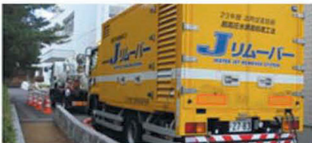
●専用の作業車両が、超高压水を発生します。
