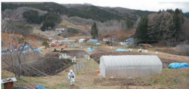
●農地の除染作業。(川俣町)
