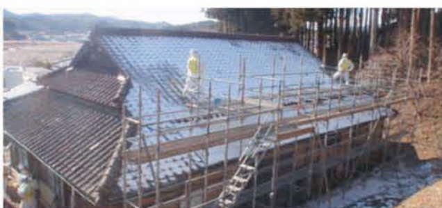
●建物(屋根)の除染作業。(飯館村)
