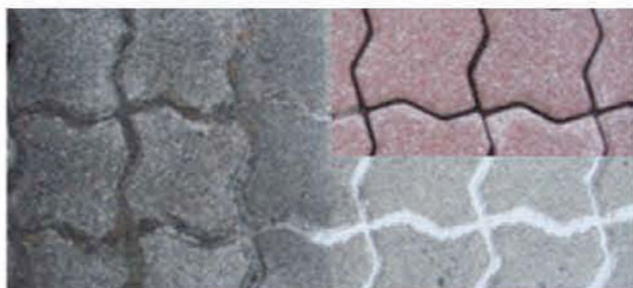
●超高压水によりレンガ同士の隙間を除染します。
